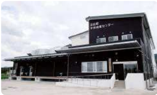
外観 鉄骨2階建
